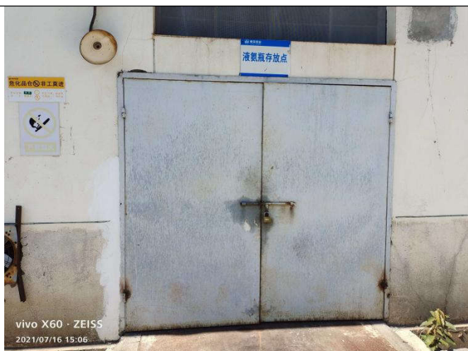
液氨瓶储存间
