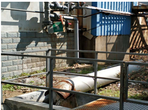
污水处理一站总排口
