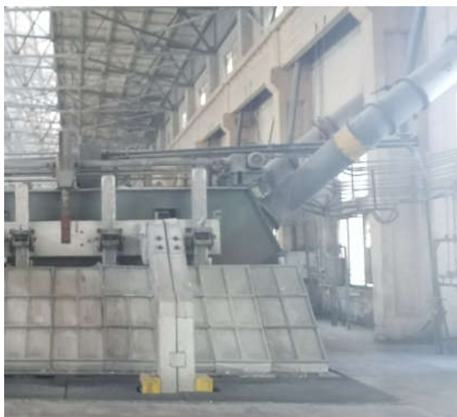
电解生产线排气管
