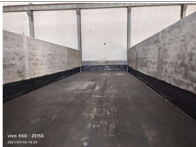
危险储存间地面防渗工程
