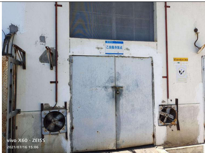
乙炔瓶储存间
