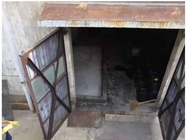
南铝氧化二车间化学药剂小桶的围堰
