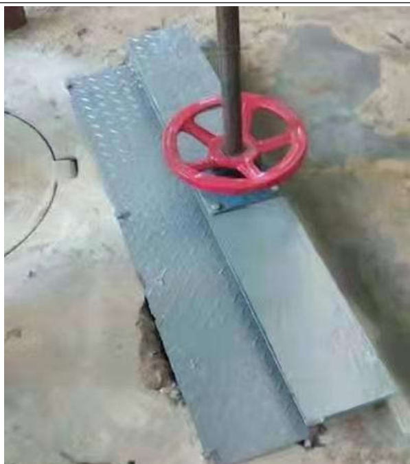
污水处理一站雨水口水闸
