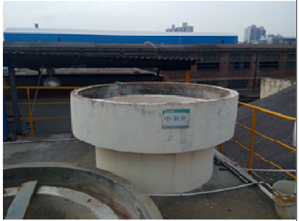
华银污水处理站中和池
