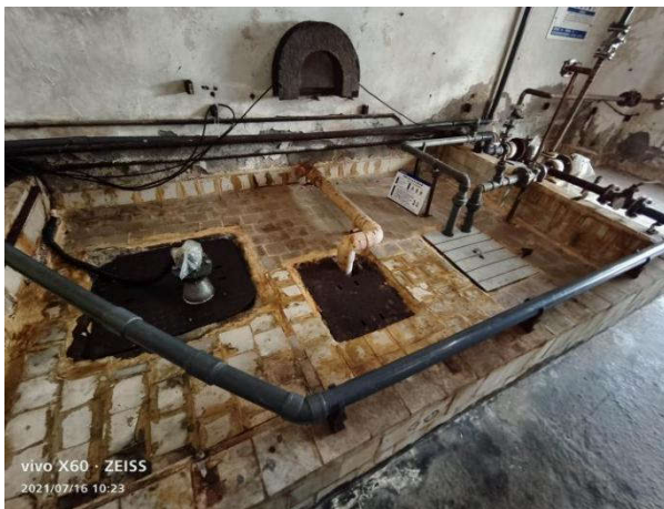
南铝氧化二车间地下碱液罐
