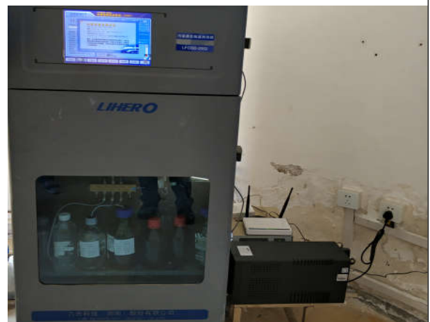
污水处理一站总排口在线监测系统
